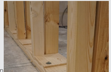
osztott vázoszlop – átmenő talp- és felső keretgerenda
